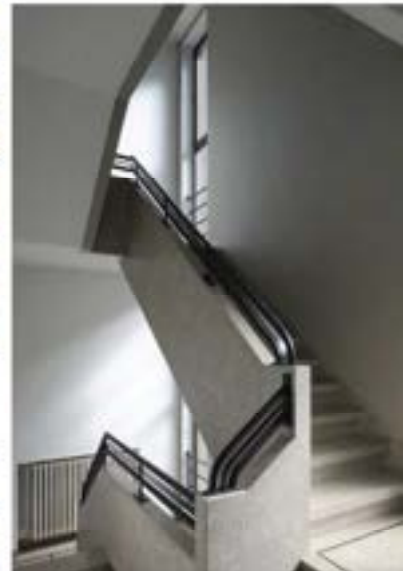
VILLA MULLER, R-S-G, 1938 VUE DE L'ESCALIER DE SERVICE ARCH. MARCEL SPIITAEEL IMAGE : © STAS BRUUX, PHOTOGRAPHIE
