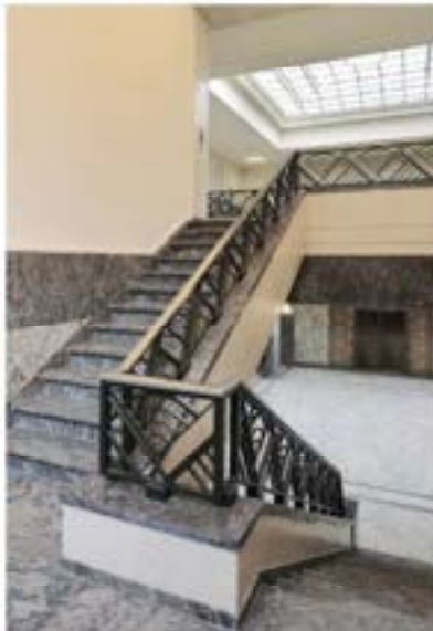
HOTEL EMPAIN, BRUXELLES, 1930 VUE DU GRAND ESCALIER ARCH. MICHEL POLAK IMAGE : © GUYARDI ET BINDER PHOTOGRAPHIE
