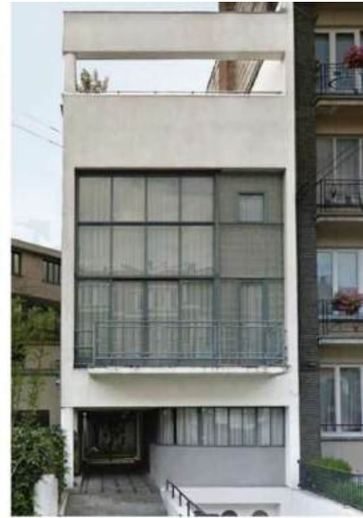
MAISON DE VERRE, BRUXELLES, 1935 VUE DE LA FACADE AVANT ARCH. PAUL-AMAURY MICHEL IMAGE : © GOOGLE STREET VIEW
