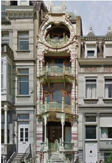
MAISON SAINT-CYR, BRUXELLES, 1903 VUE DE LA FACADE AVANT ARCH. GUSTAVE STRAUVEN IMAGE : © GOOGLE STREET VIEW
